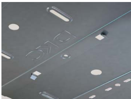
Предварительная безвинтовая фиксация
